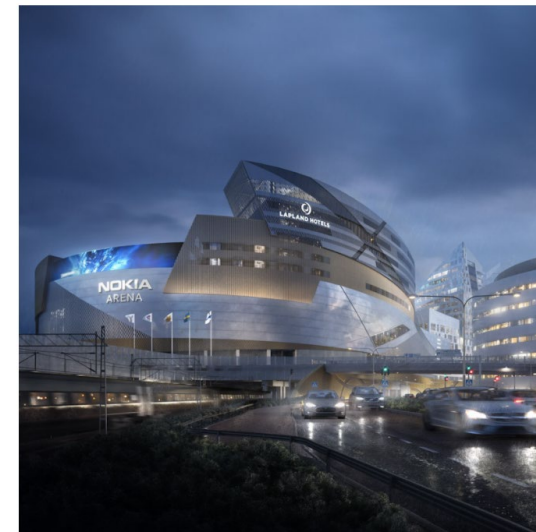
AREENA LÄMMÖNTALTEENOTTO LÄMPÖPUMPPU NOKIA AREENA, TAMPERE
