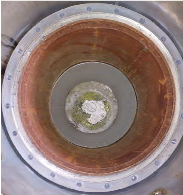
KUVA 22. Reaktoriin asennettu kartio.
